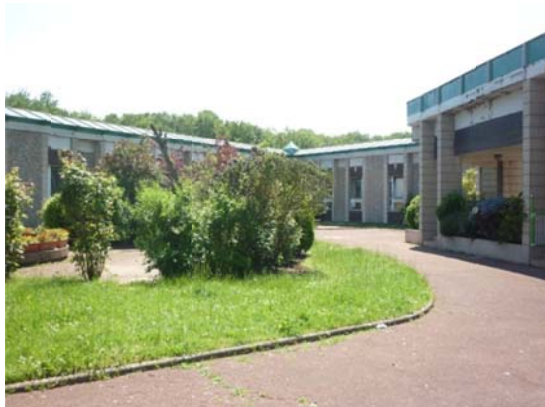
Foto 21: Vista do pátio interno.
