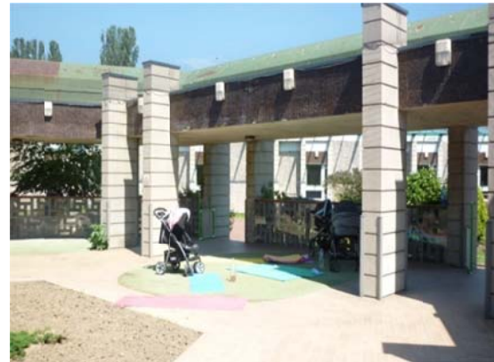
Foto 22: Passarela coberta no pátio interno
